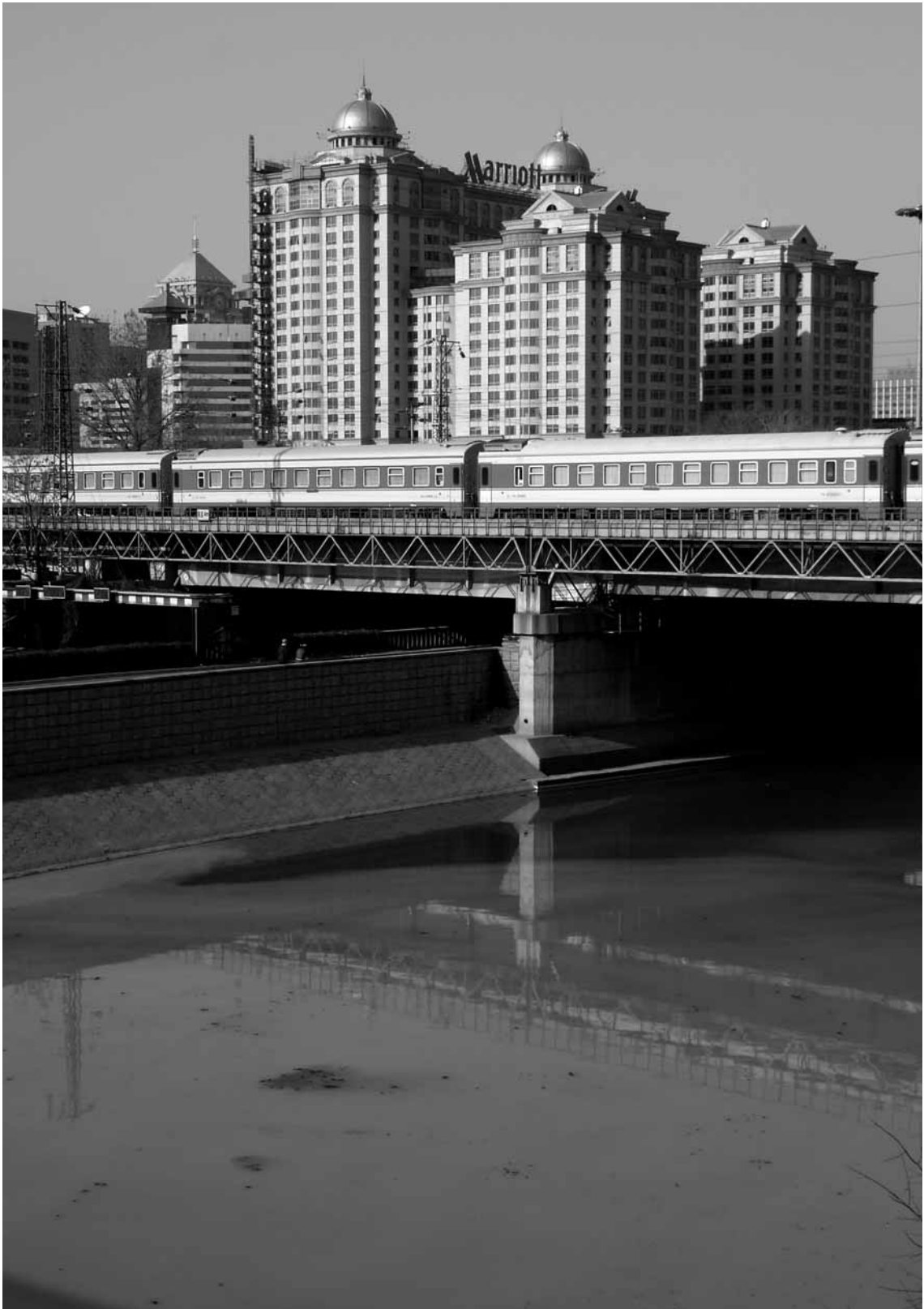
Canal d'évacuation des eaux usées à ciel ouvert, en plein centre-ville de Pékin. © Adeline Cassier, 2007.
